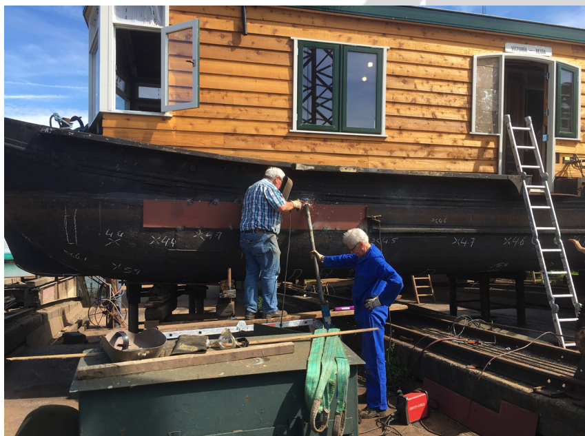
Tervrijl de mannen van de Museumwerf de platen vastlassen, houdt Guus binnen de brandwacht
